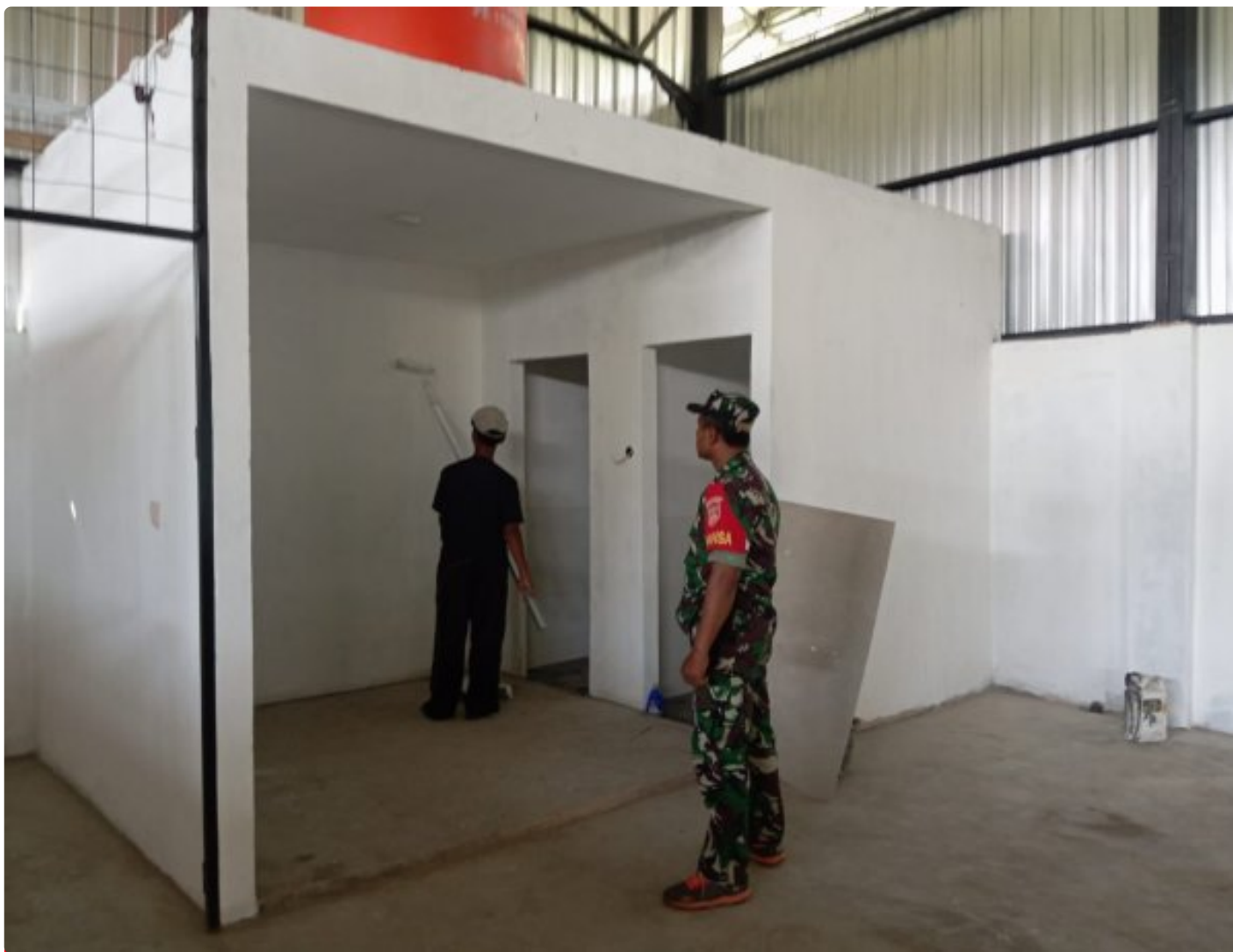
Babinsa Monitoring Pembangunan KDKMP, Pastikan Progres Sesuai Rencana
