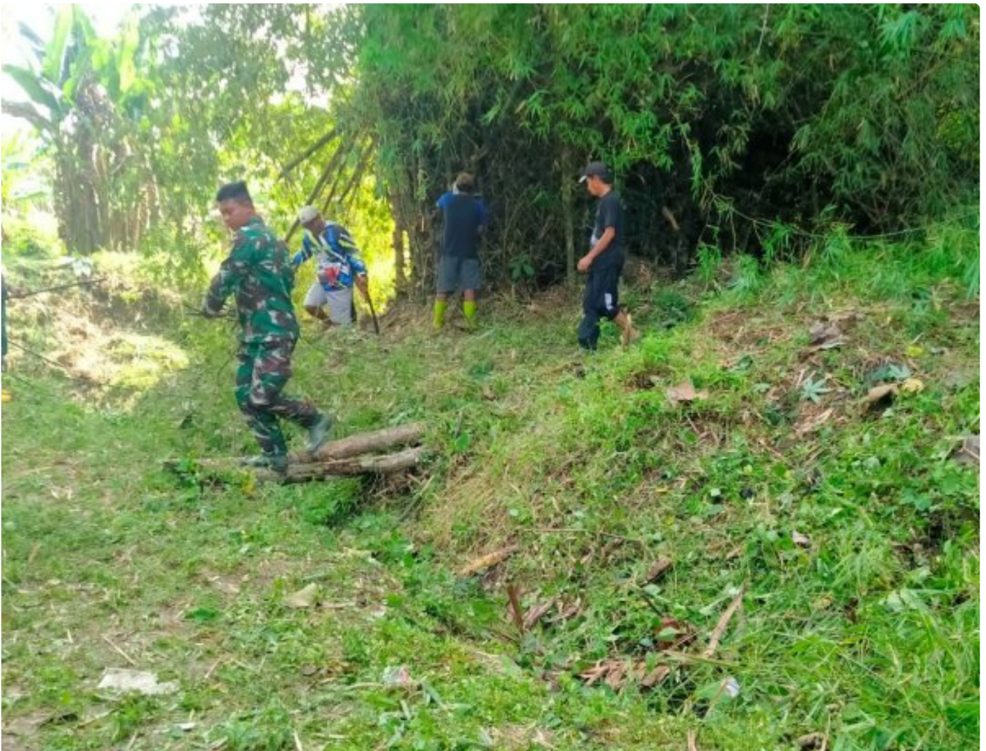
Karya Bakti Koramil Cawas Bersama Warga, Dukung Pembangunan Jembatan Garuda di Desa Burikan
