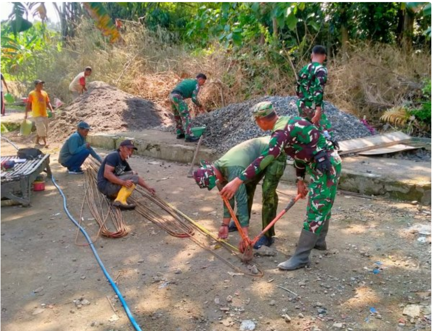
Masuk Tahap Pondasi, Pembangunan Jembatan Garuda Di Desa Burikan Terus Berlanjut
