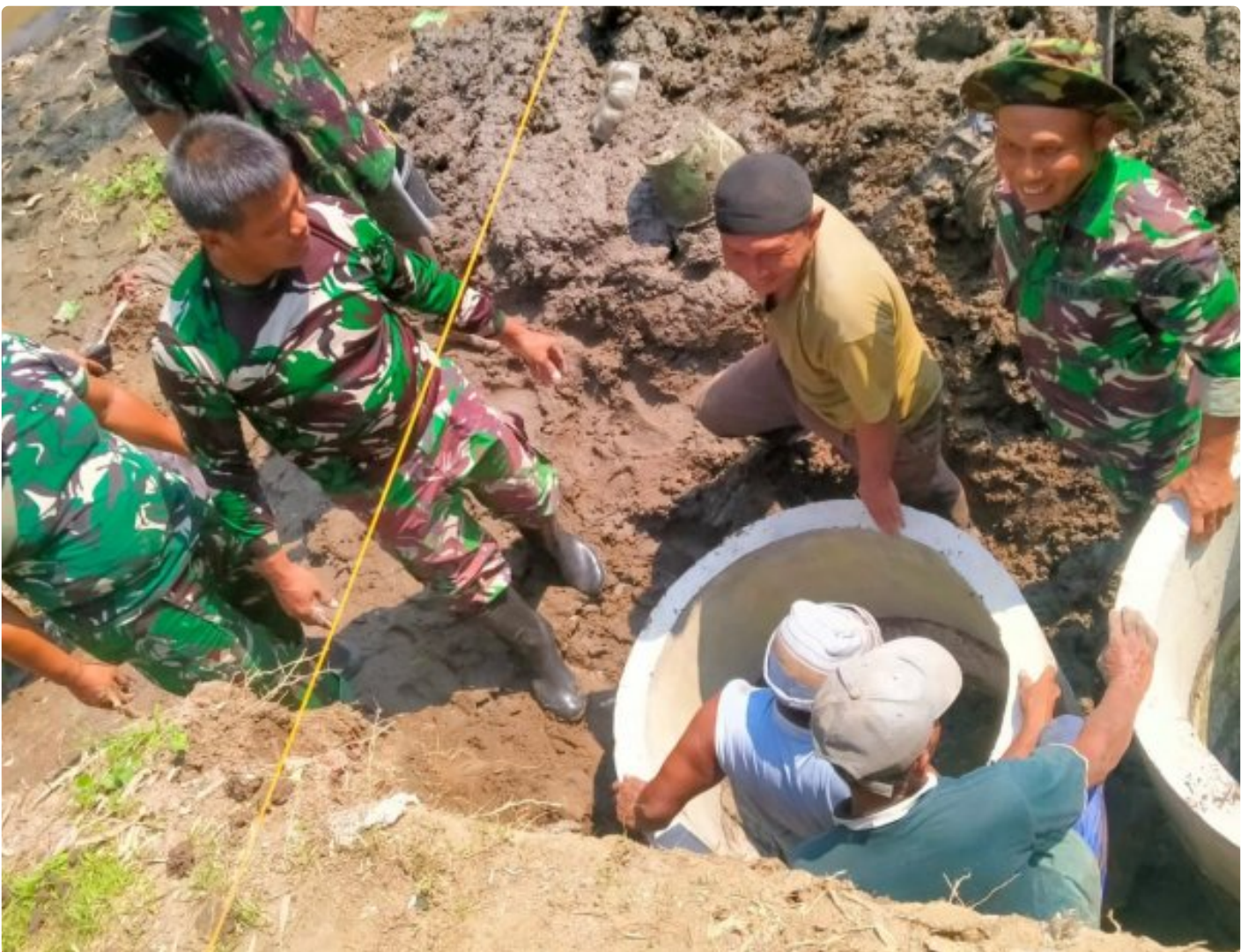
Pembangunan Jembatan Garuda Di Desa Burikan Masuki Tahap Pemasangan Bis Beton Pondasi
