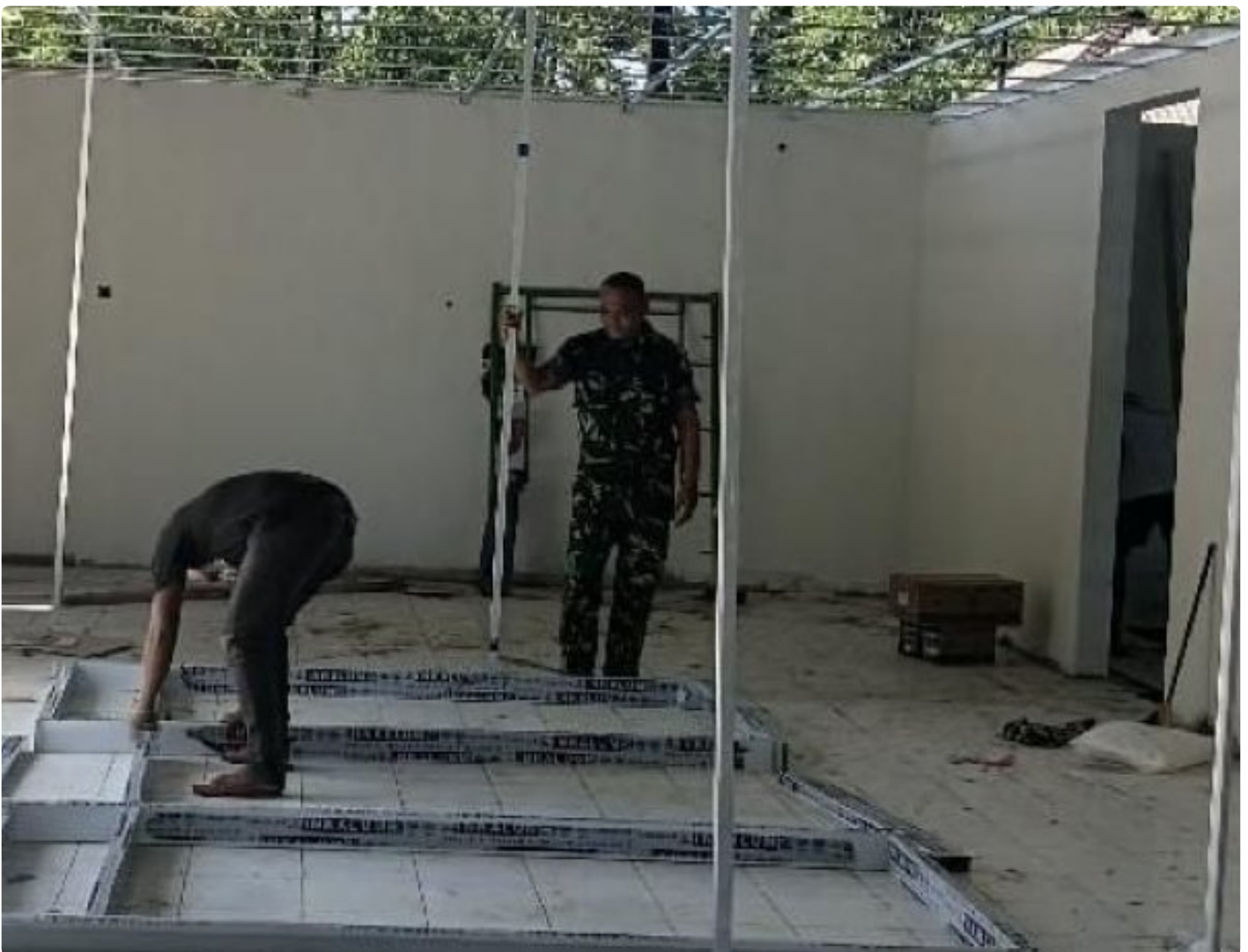
Pengawasan Babinsa Pastikan Pembangunan KDKMP Desa Logede Berjalan Sesuai Target
