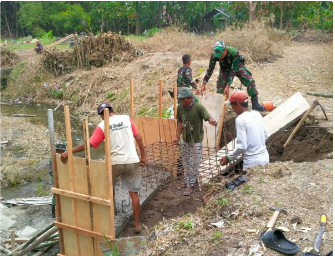
Sinergi TNI Dan Warga, Pengecoran Jembatan Garuda Di Cawas Berjalan Lancar
